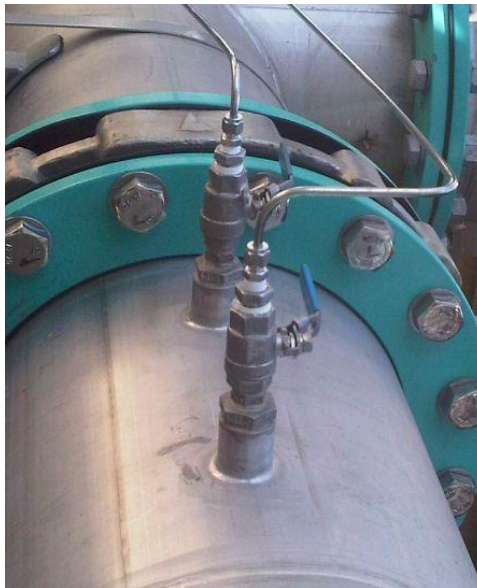
Figure 9 - Ensemble vanne à boisseau sphérique
